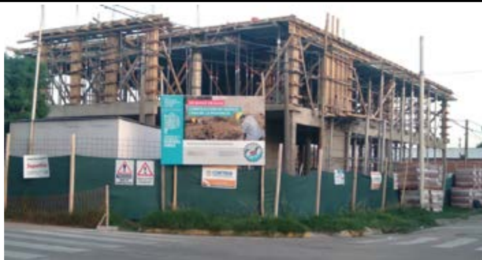
Buen ritmo de obra de la futura "Casa de la Provincia", ubicada en Mendoza y Alsina (Fotos De Sogós).
