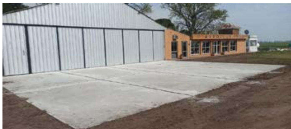
La sede del Aero Club será el lugar elegido en la importante jornada sobre seguridad y aplicación de agroquímico (Foto De Sogós).
