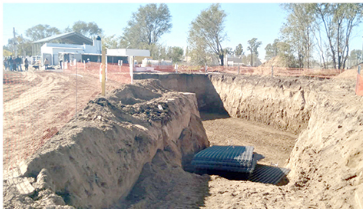
Importante obra de la nueva cisterna que se realiza en la planta de ABSA. Foto De Sogós
