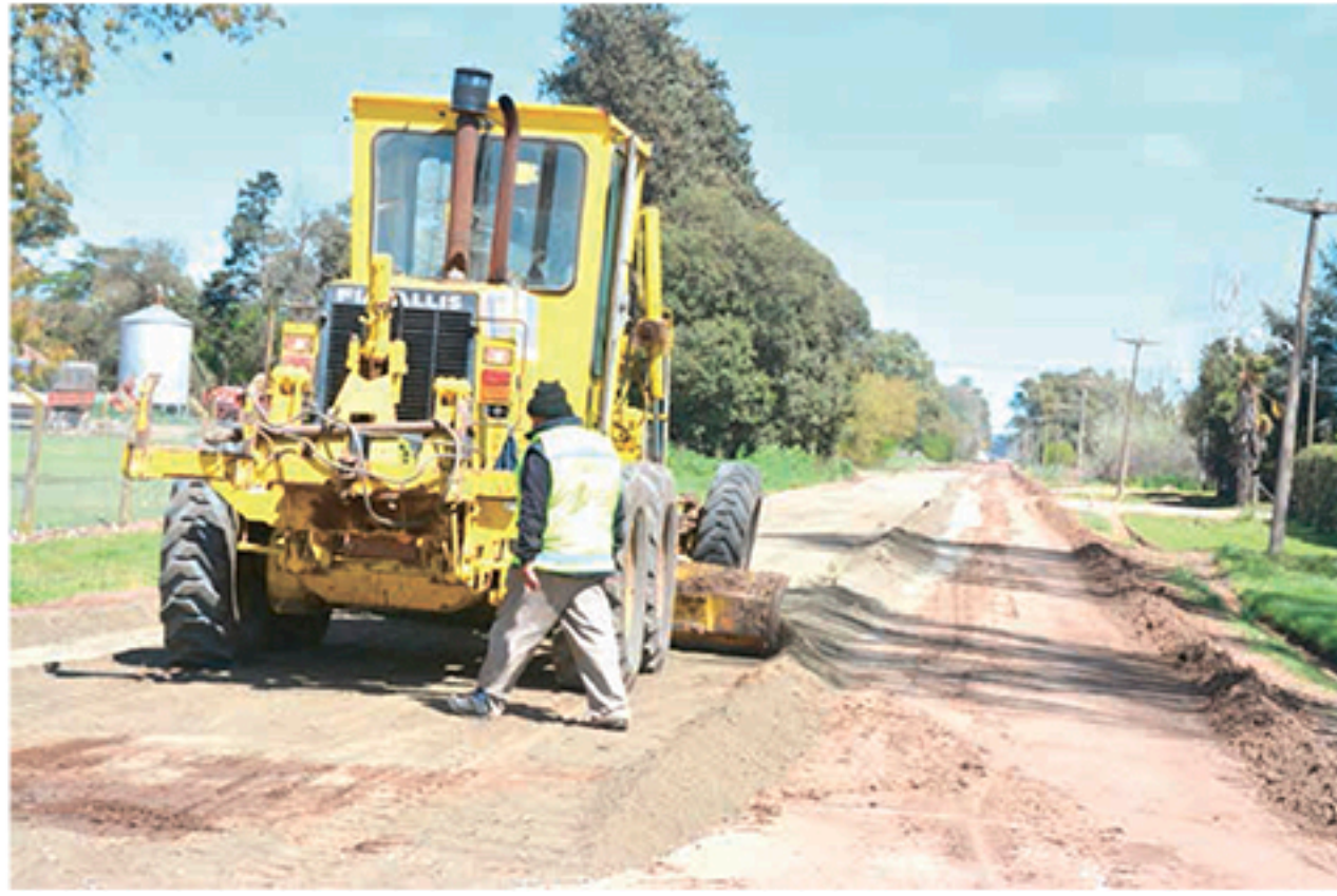
Se trabaja en el nivelado del piso del camino continuación de Av. Mitre y ruta 65.
