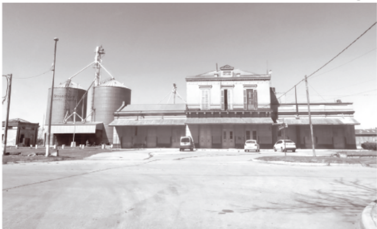
Comenzaron los trabajos en la estación con refacciones en el edificio, los baños, pisos y pintura en general, y el plazo para finalizar los trabajos es de 30 días. Foto De Sogos.
