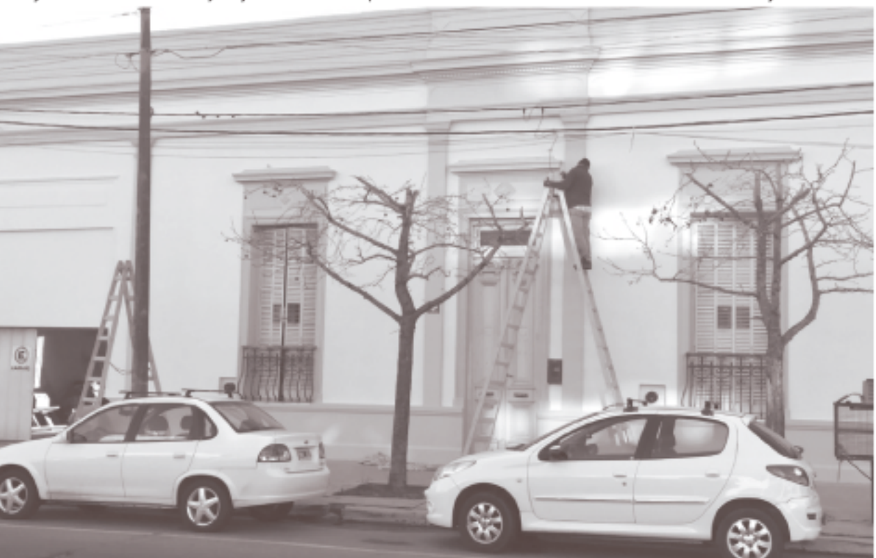
Trabajos de pintura y refacción que se realizan en la sede de Cáritas. Foto De Sogós.
