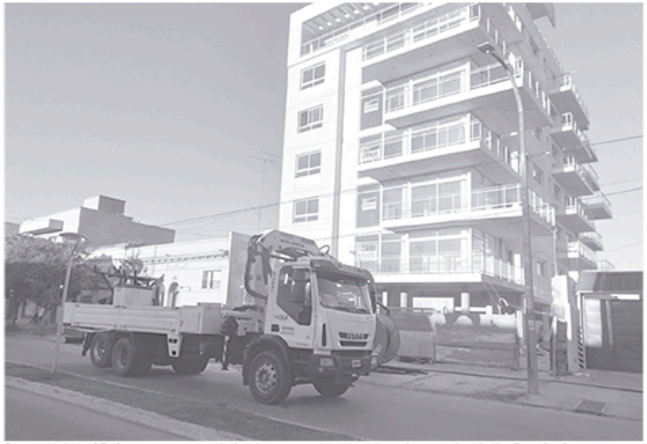
Personal de la CEyS se encuentra trabajando en un cableado subterráneo en Av. Vedia. Foto De Sogós.
