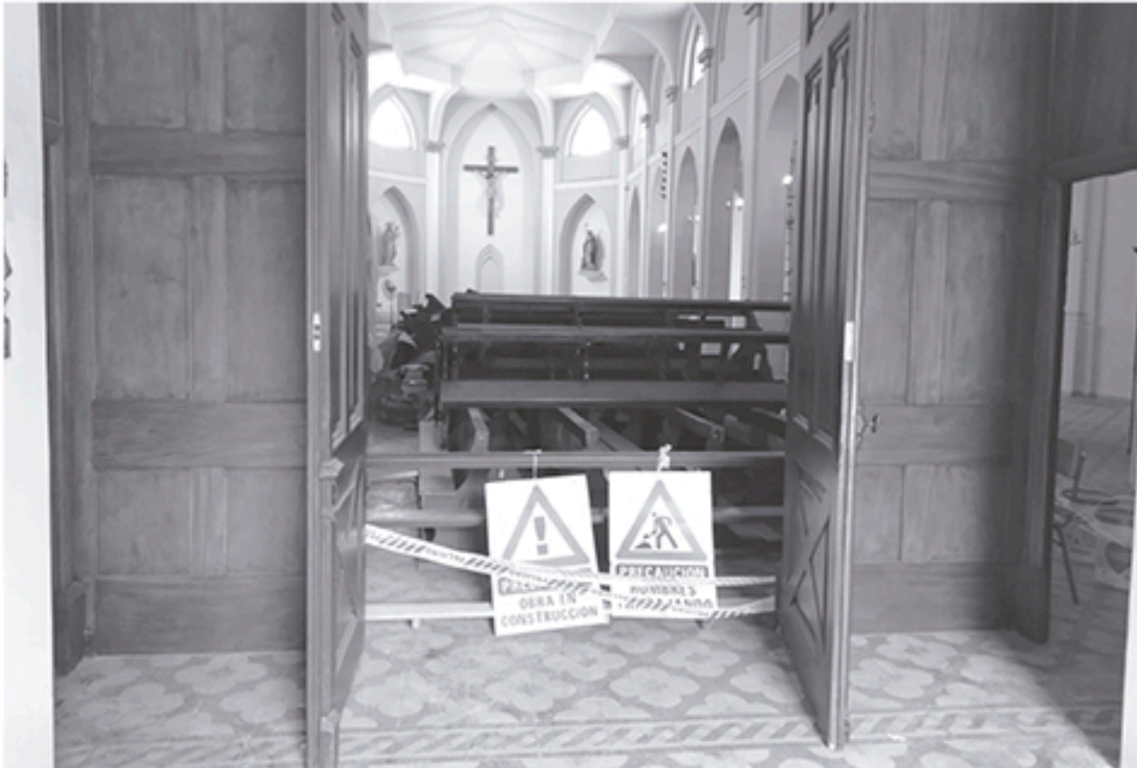
La imagen muestra los trabajos que se realizan en la Iglesia Catedral. Foto De Sogós.
