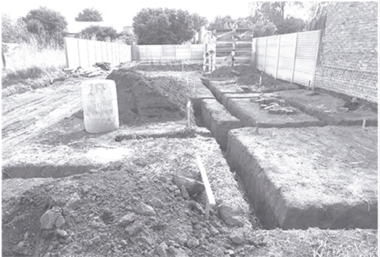
Vista de los cimientos de la casa que será el premio del sorteo final de la rifa que se realizará en el mes de marzo del 2022. Foto De Sogos.
