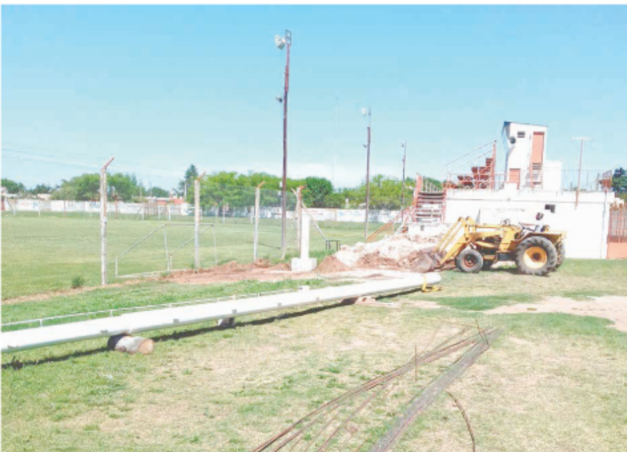
Vista de las importantes obras que lleva adelante el Club Atlético 9 de Julio.
