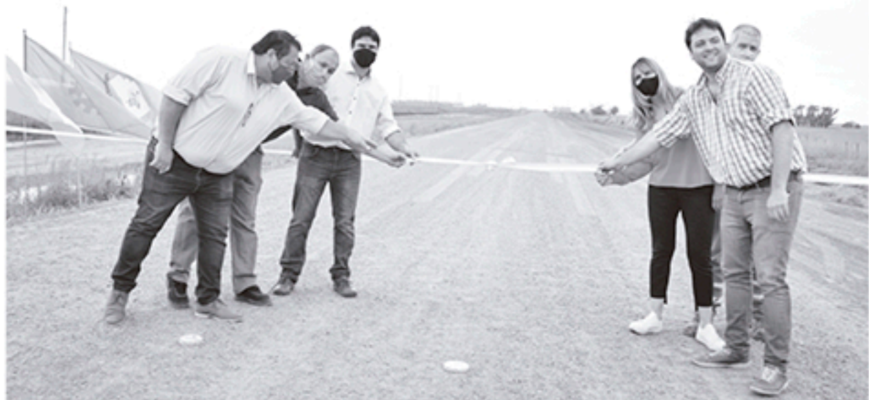
Autoridades municipales realizan el corte de cintas dejando inaugurado el estabilizado de piedras del acceso a Patricios. Prensa Municipal.
