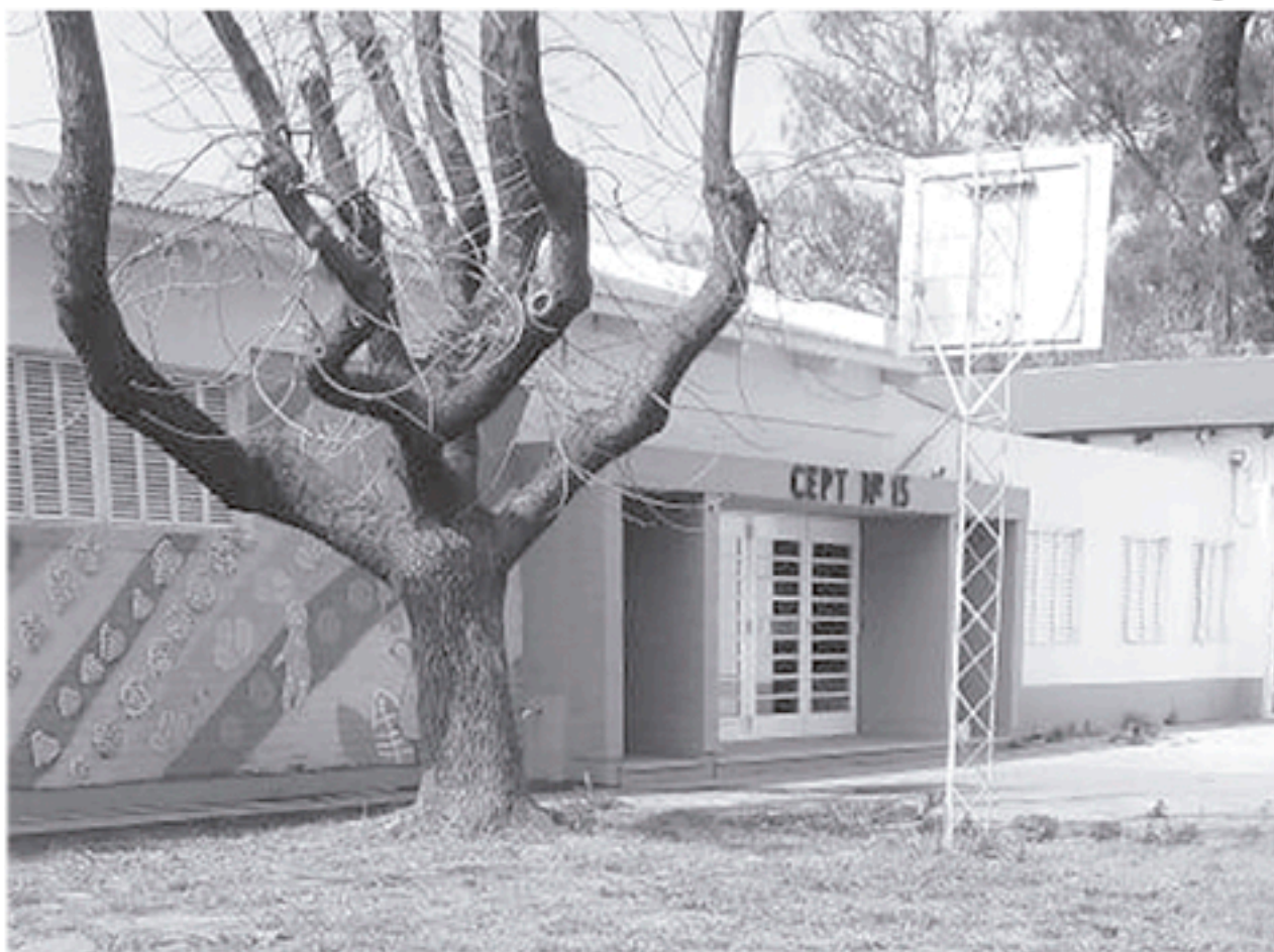
Vista del establecimiento educativo ubicado en la zona de El Chajá. Foto De Sogos.
