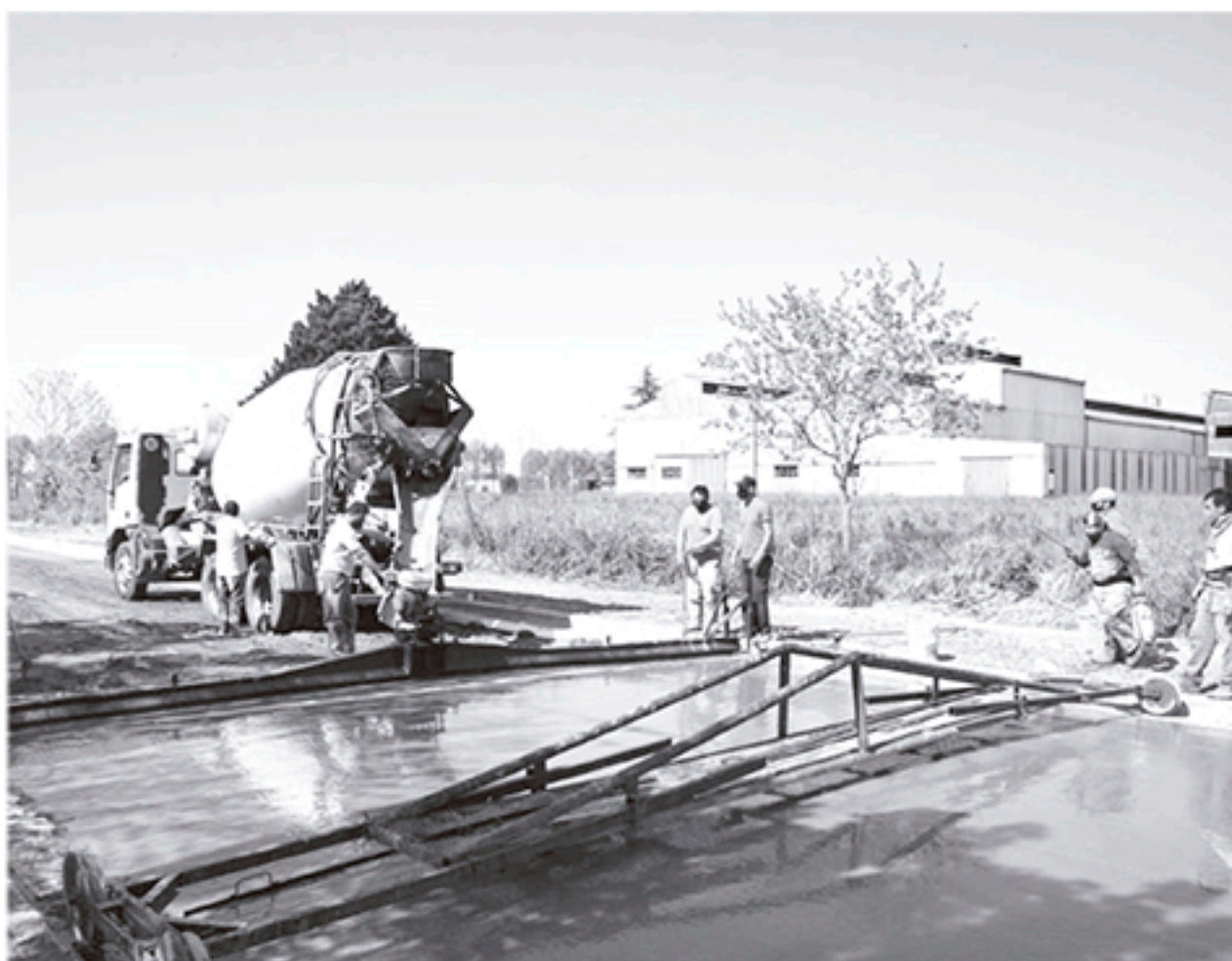
Vista de los trabajos que se realizan en calle San Juan. Prensa Municipal.
