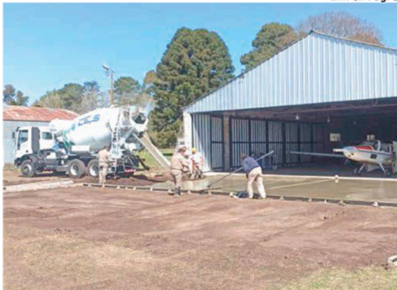
El Aero Club realizó una plataforma de hormigón en la entrada del hangar al lado del buffet.
