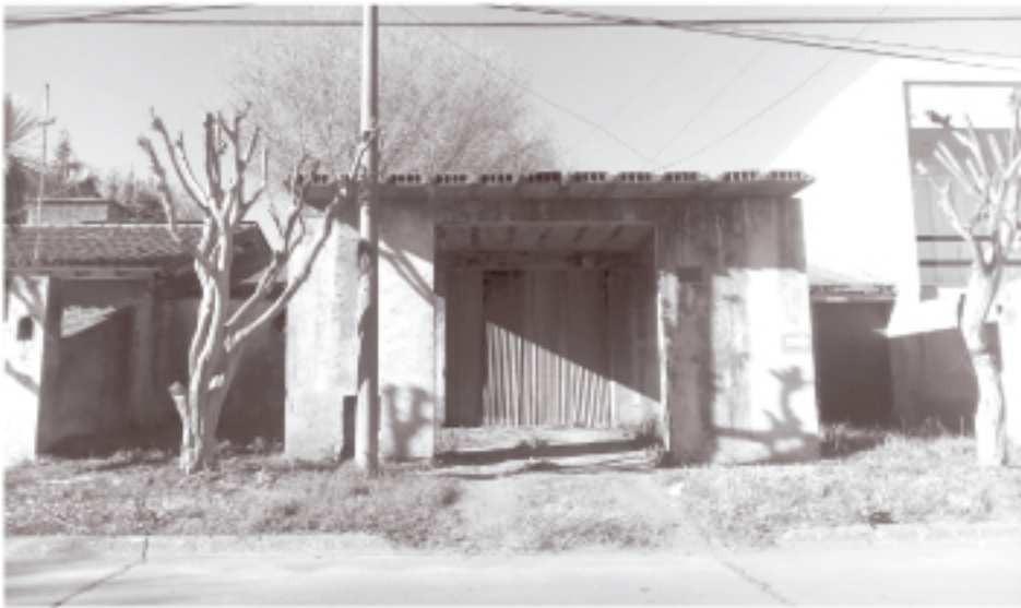
Vista del frente de la sede de Sociedad de Fomento ubicada en calles Tucumán y Joaquín V. González. Foto De Sogós.
