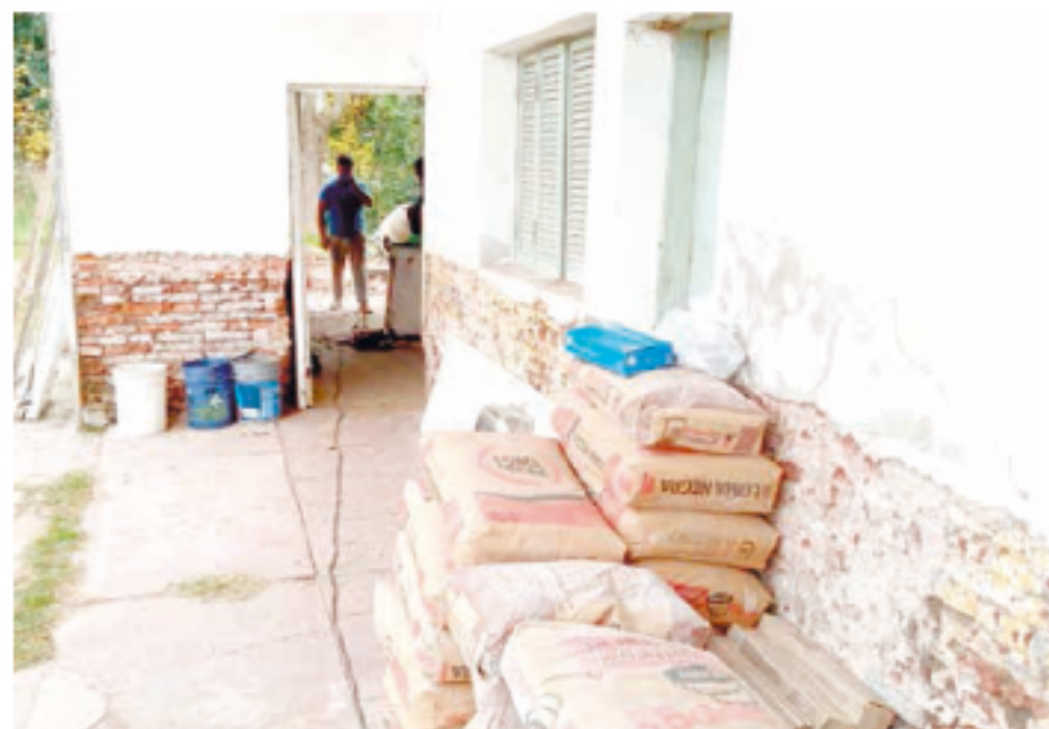
La imagen muestra parte del destacamento que se está refaccionando.
