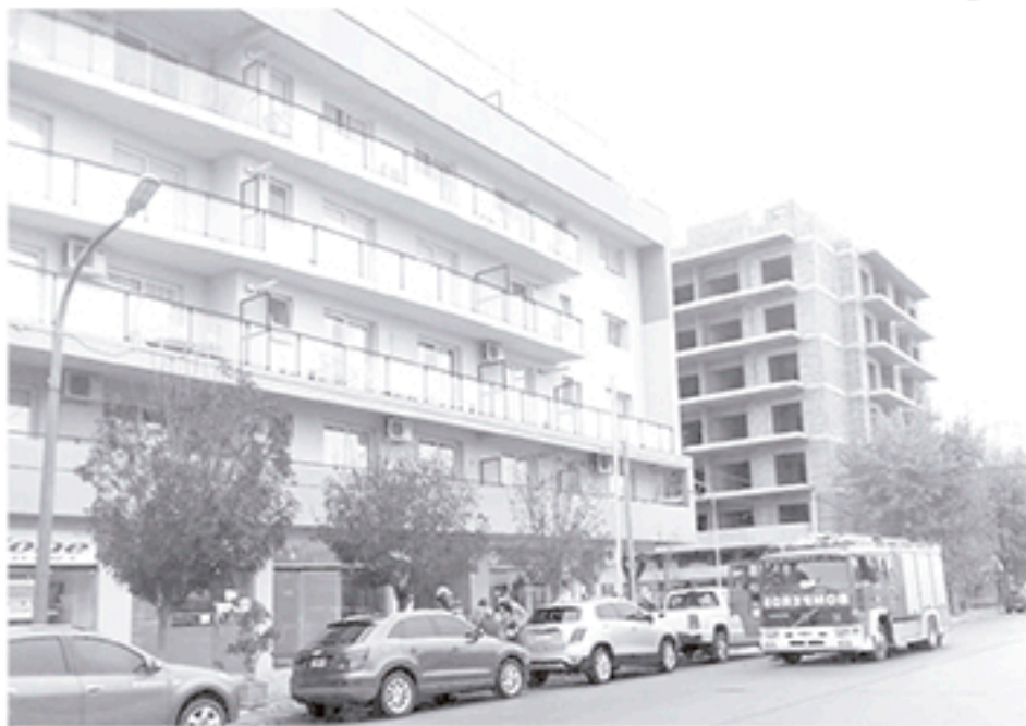
Sus en pleno centro al tomar fuego un departamento en el 5to. piso del edificio de San Martín y Robbio. Foto De Sogós.
