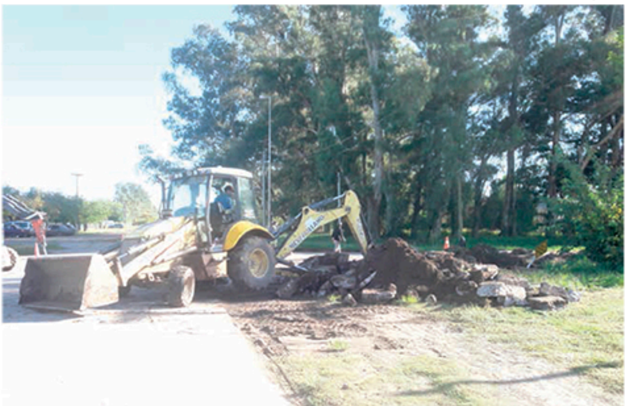
Vista de los trabajos que se realizan en cercanías del ex Matadero. Prensa Municipal.
