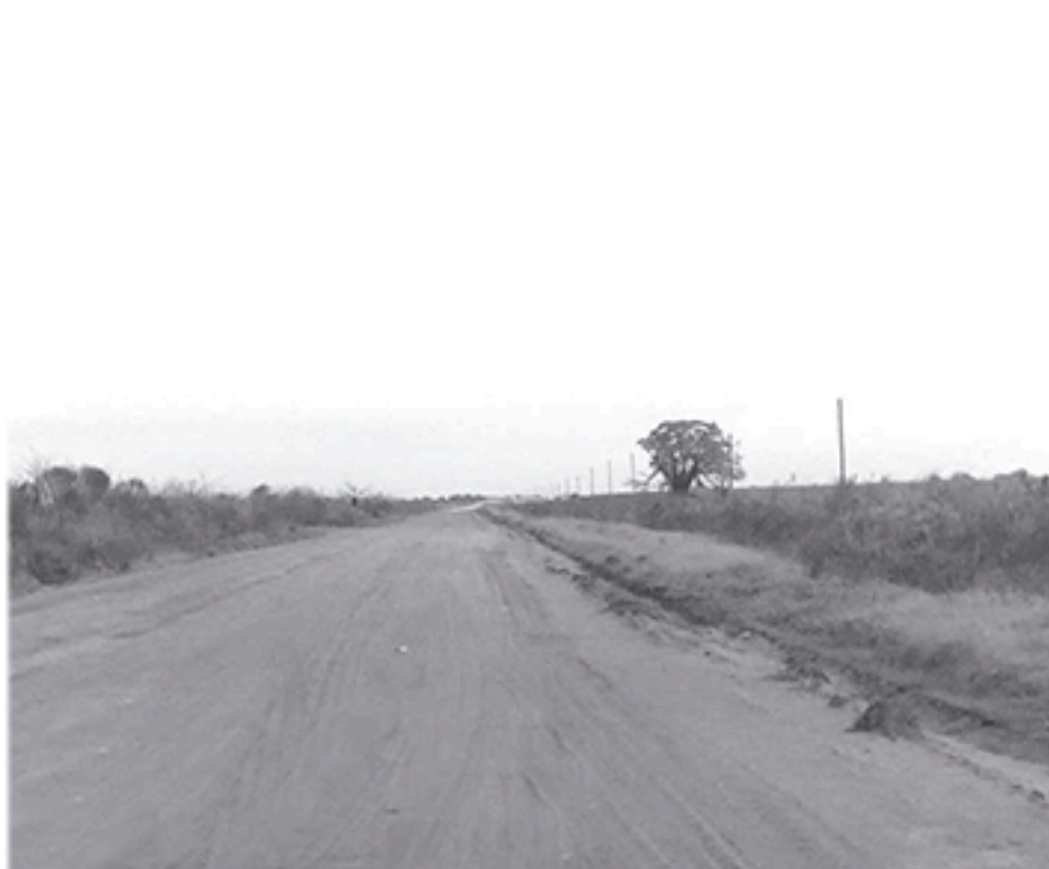
Vista del acceso de los 6km cuyo piso será estabilizado con piedras.
