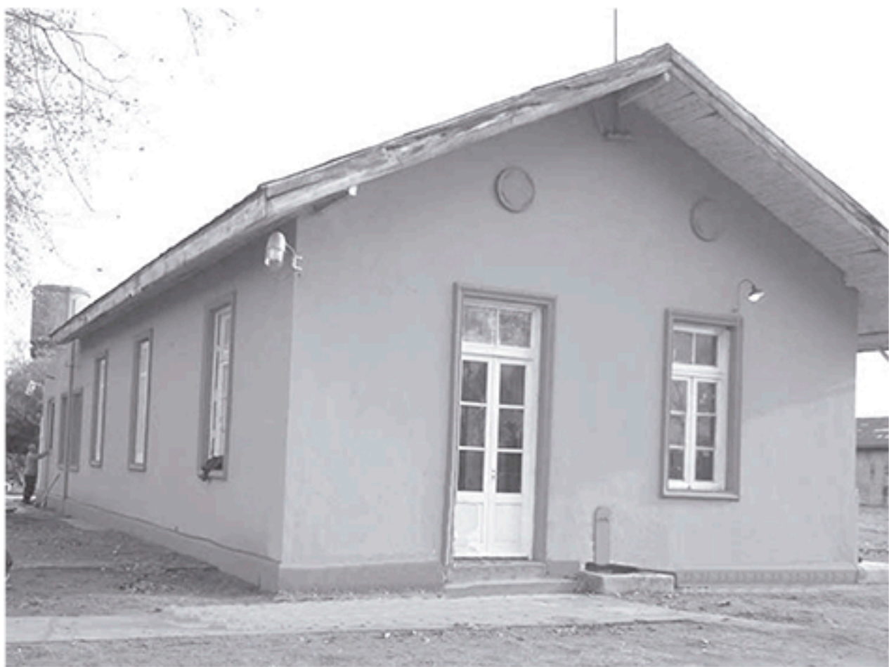
Frente del edificio que será usado como destacamento de Bomberos Voluntarios.
