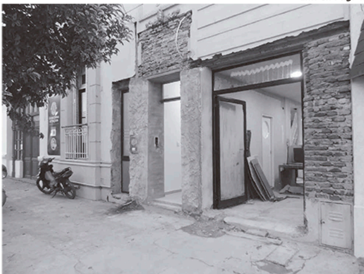
Vista del frente de la sede del Club de Leones donde se observan los trabajos de refacción. Foto De Sogós.
