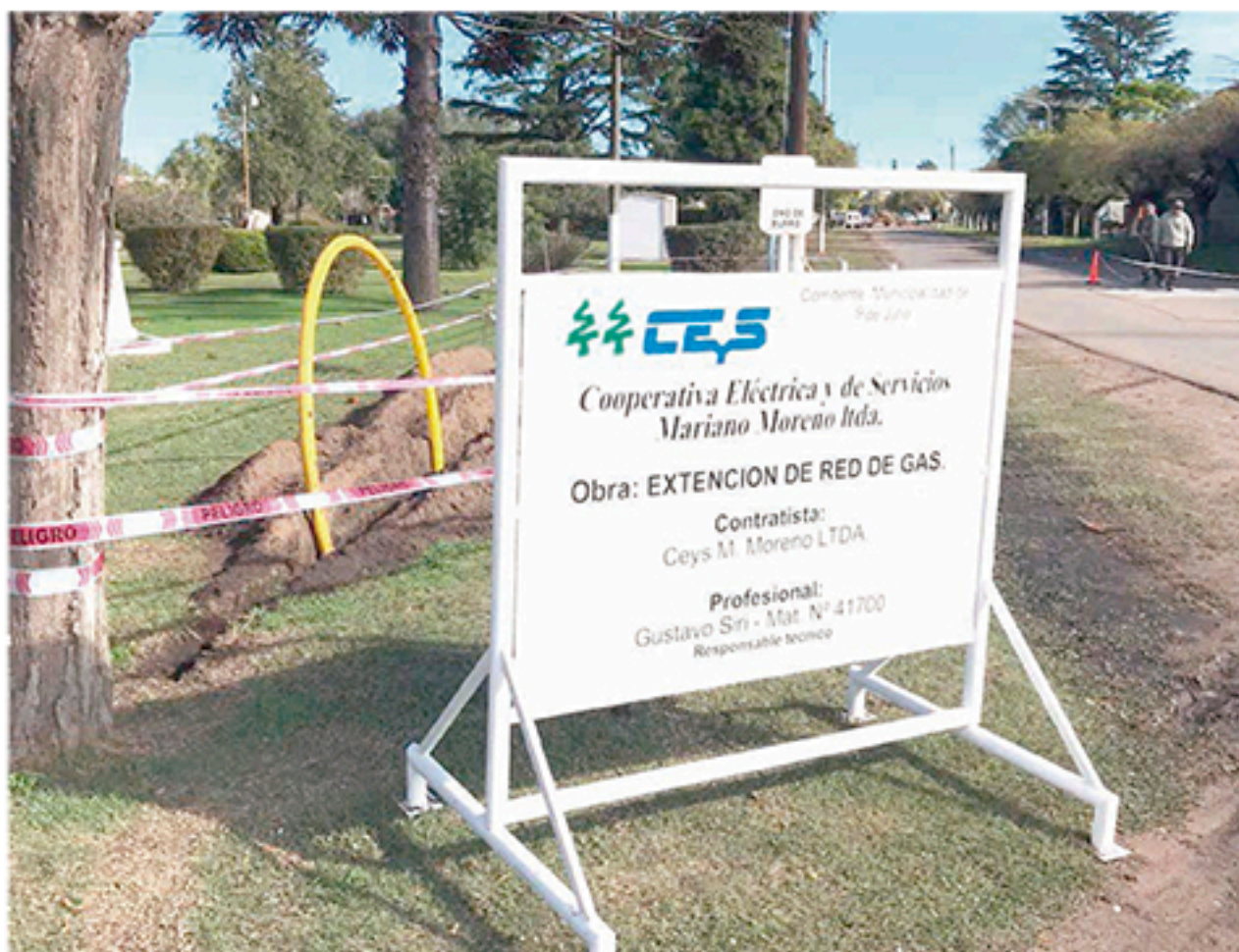
Vista de los trabajos de obra de gas para El Provincial las que empezaron a gestionarse en el 2013.
