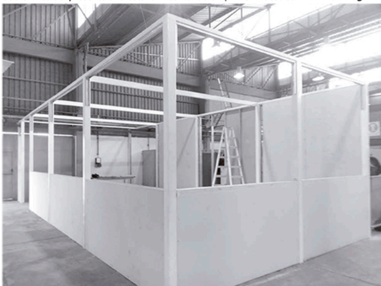
Vista del armado de la nueva aula donde funcionará el importante proyecto educativo. Foto De Sogos.
