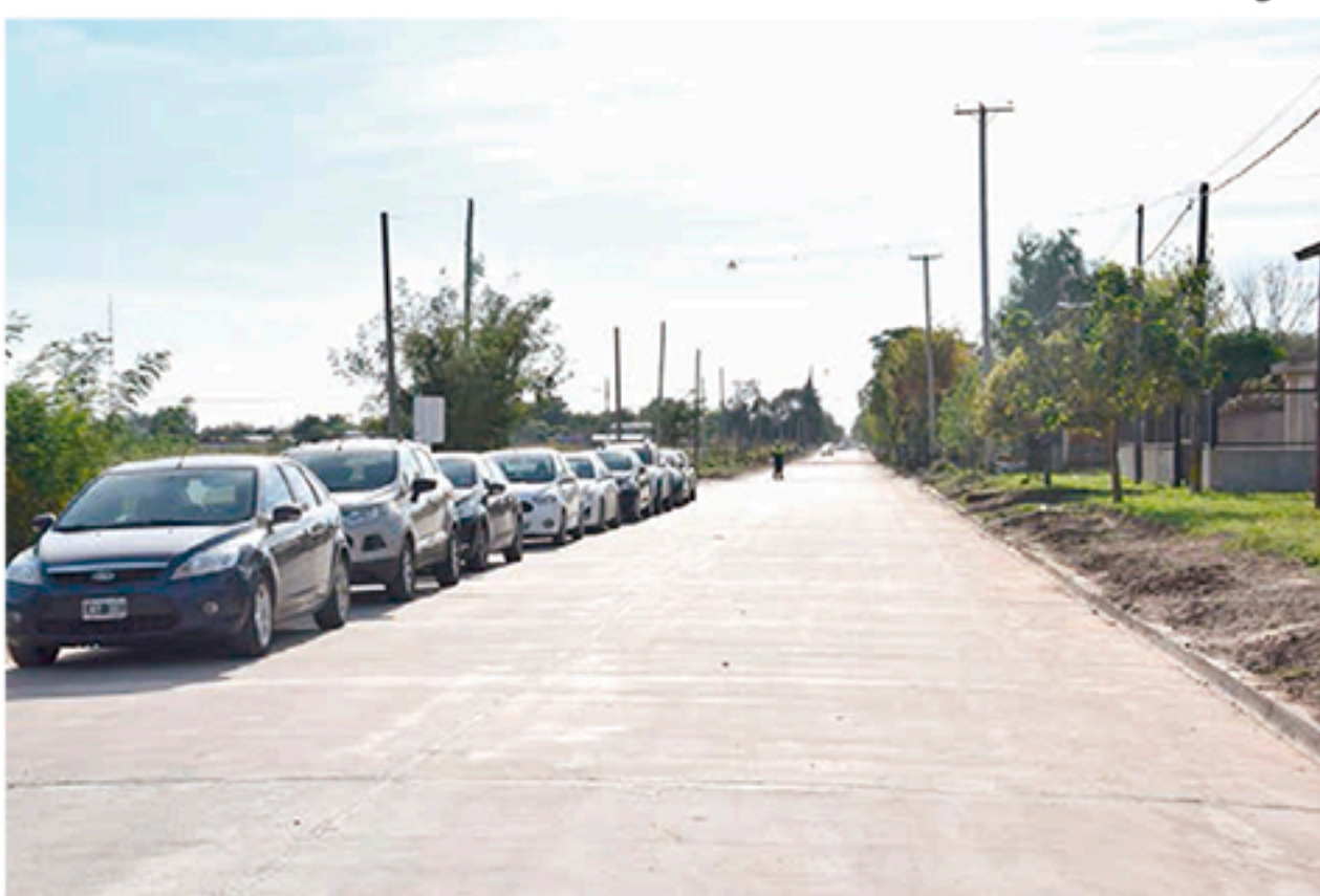
Imagen de la ya anunciada obra de pavimentación de calle Moreno. Foto Prensa Municipal.
