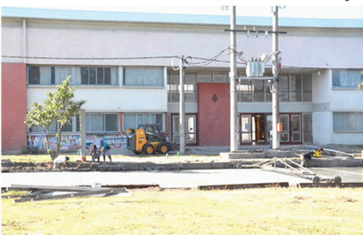
Obras de pavimento sobre calle Mariano Moreno.
