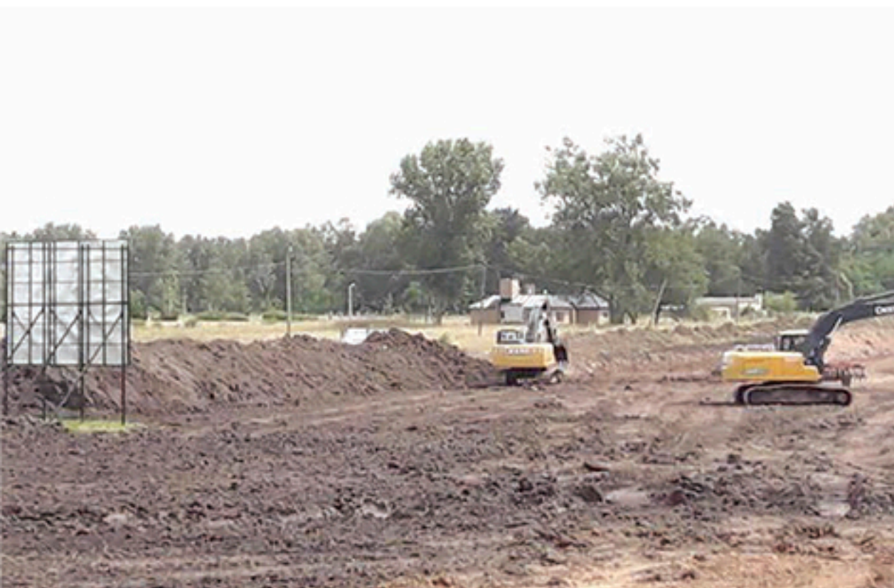
Máquinas viales que se encuentran trabajando en la ciudad de Suipacha.
