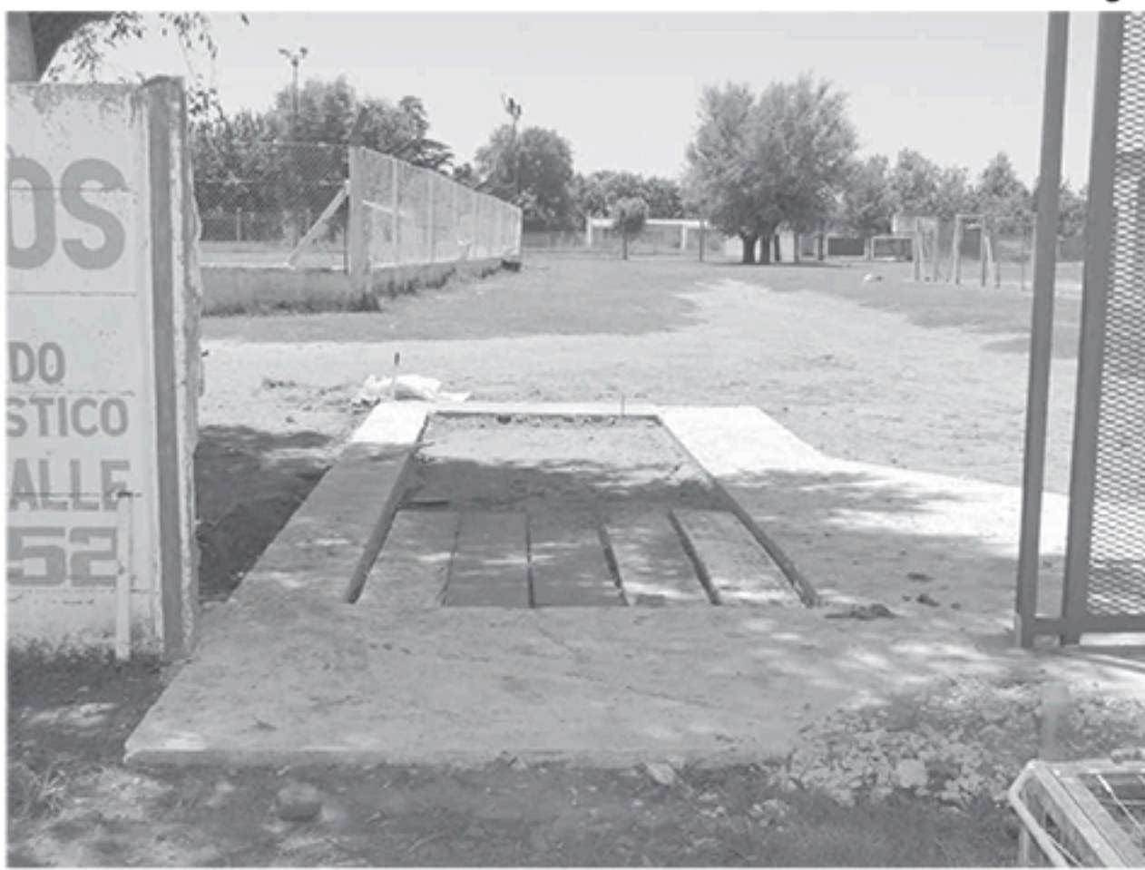
Vista de la obra que lleva adelante el club donde será instalado un módulo que cumplirá el rol de boletería y secretaría. Foto De Sogos.
