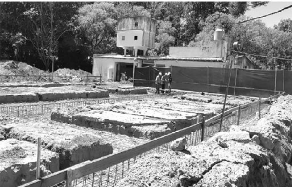
Vista de las obras que se realizan en el Hospital de nuestra ciudad.
