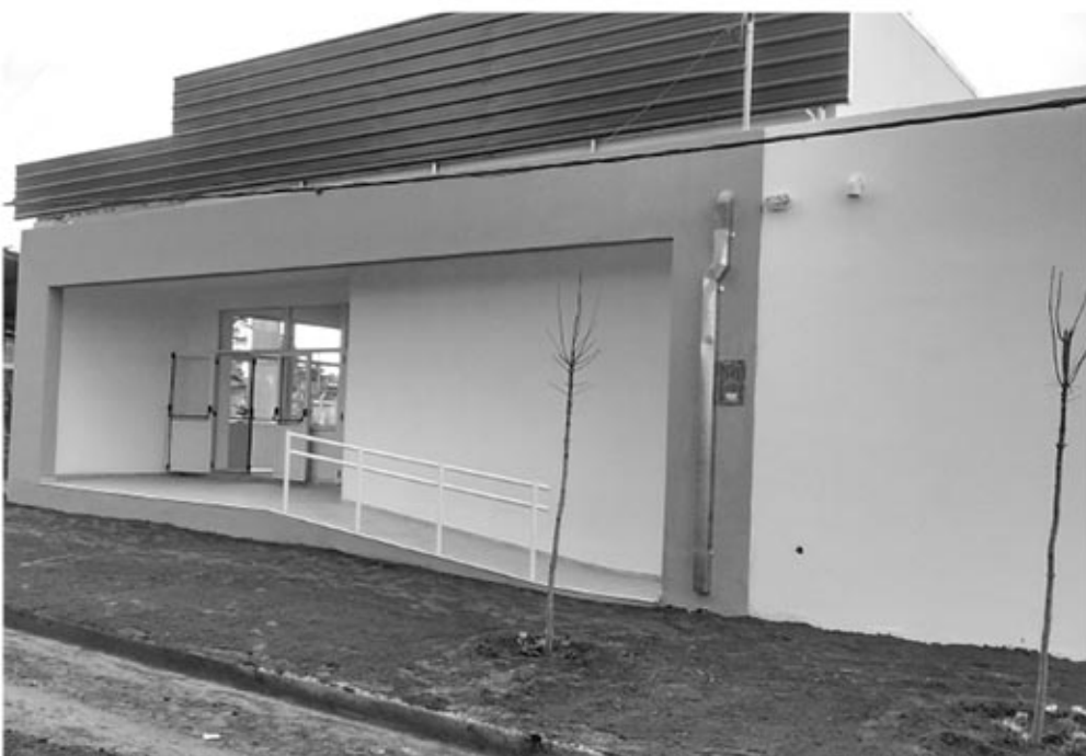
Frente del edificio del nuevo espacio comunitario ubicado en calle Balcarce y Cavallari. Foto De Sogós.
