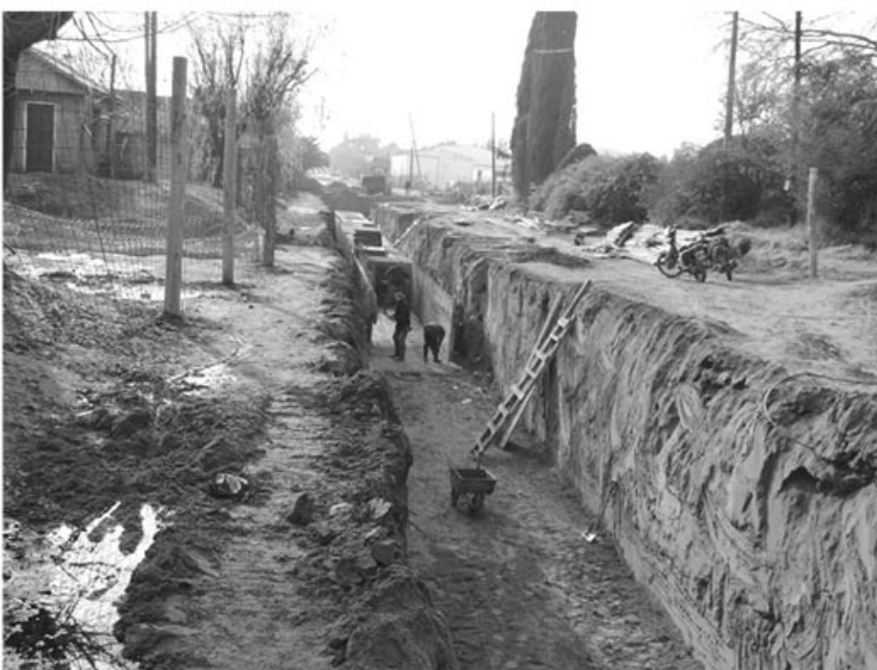
Vista de los trabajos de desagües en el sector de Ciudad Nueva. Foto De Sogos.
