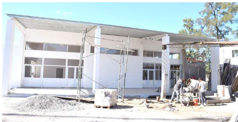
Vista de los trabajos realizados .
