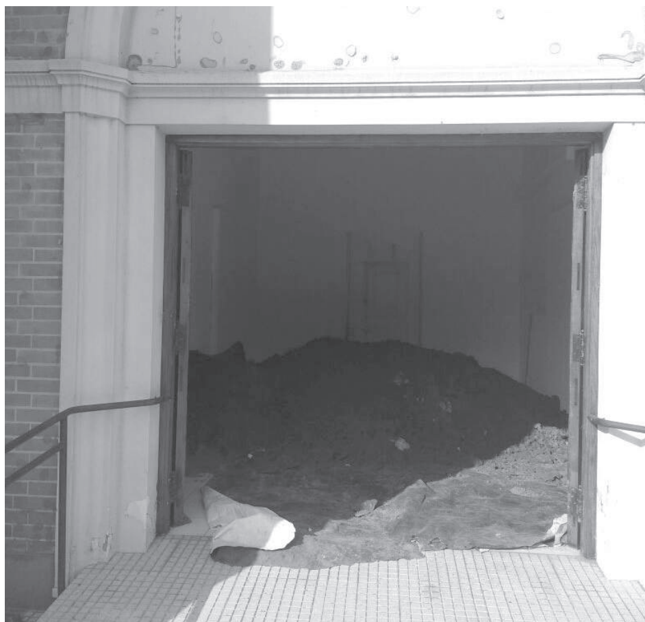
Portada lateral de la Iglesia Catedral donde se realiza la obra.
