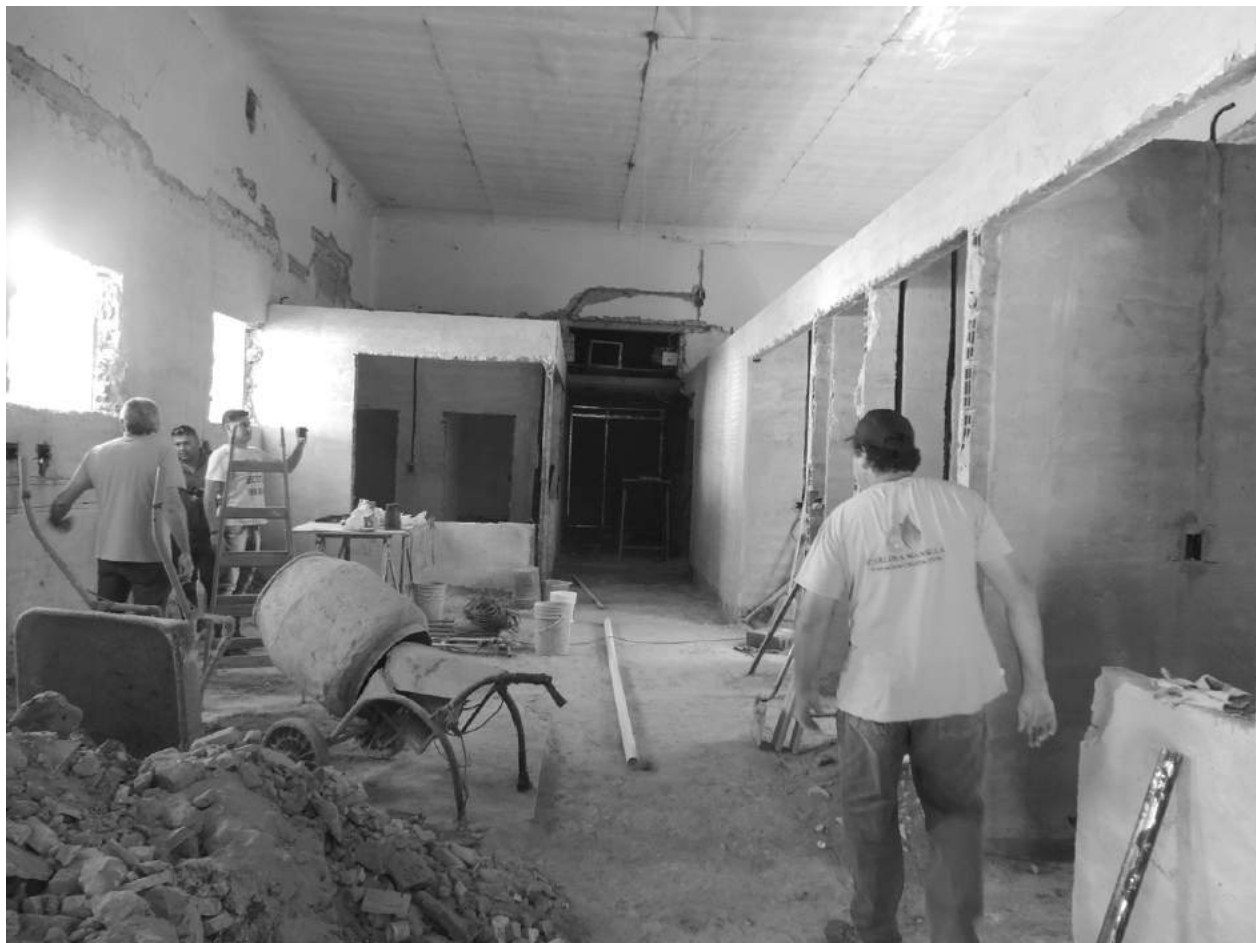
Avanzan las obras del Hospital en lo que será Terapia Intensiva. Foto De Sogos.
