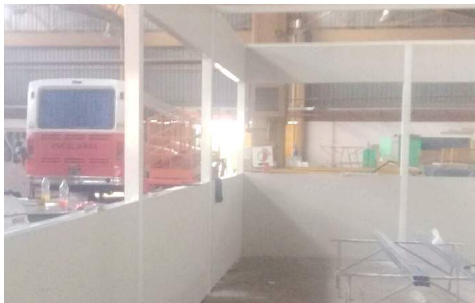
Vista de las obras que se realizan en la EEST Nro. 2.
