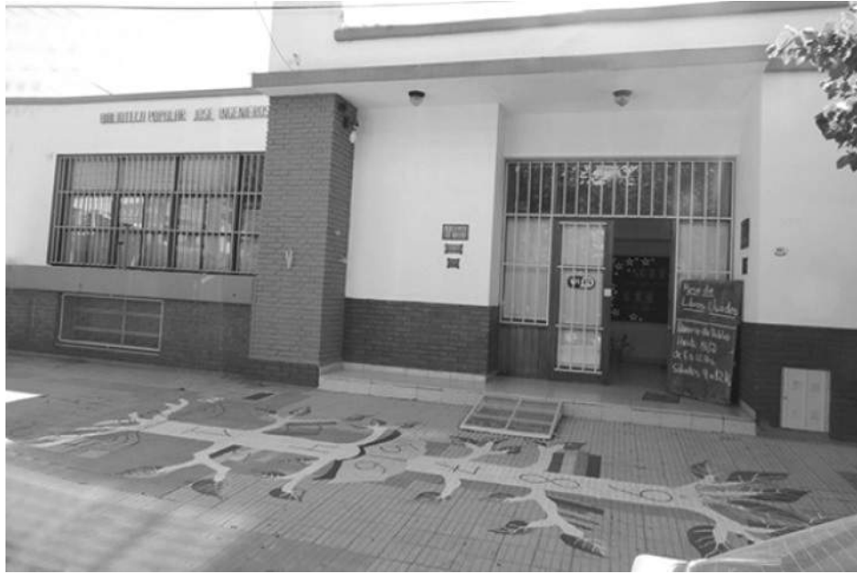
Avanzan las obras de sanitarios que lleva adelante el espacio cultural.
