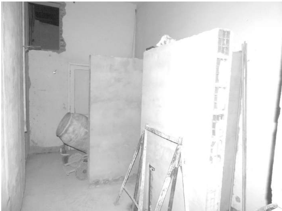
Avanzan las obras de baños para personal con discapacidad.
