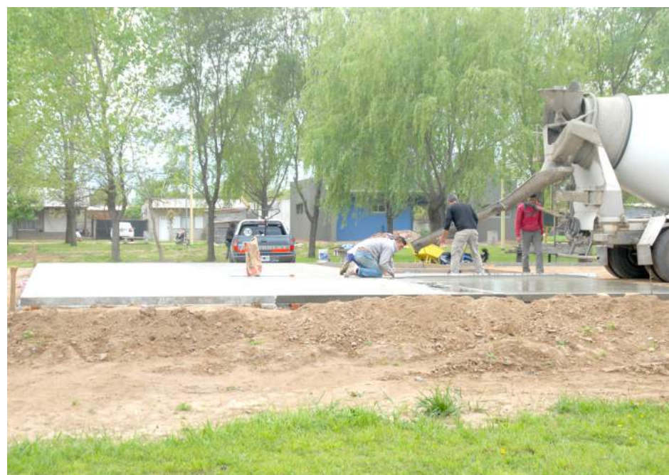
Vista de los trabajos que lleva adelante el municipio.
