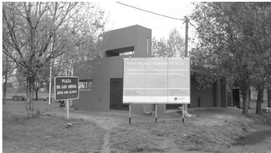
En la Plaza Jesús Abel Blanco se construye el polideportivo.
