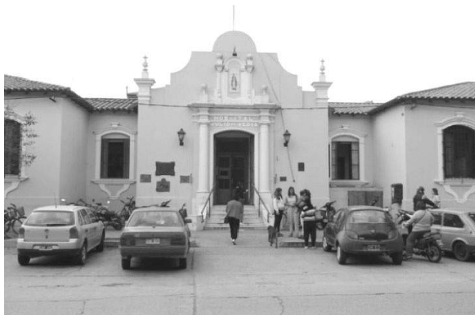
El Hospital entre obras y falta de profesionales. Fotos De Sogós.
