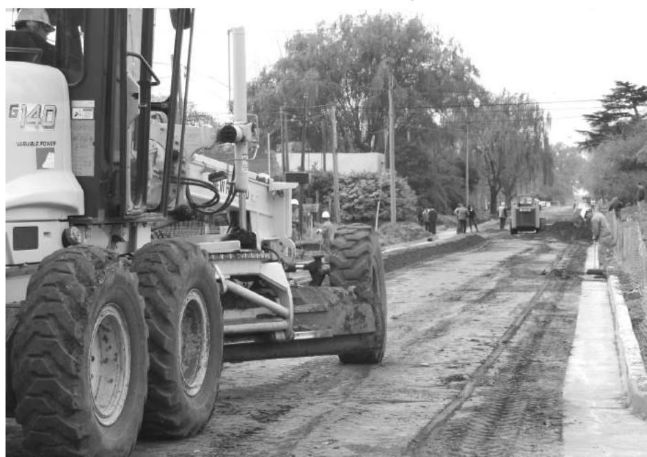
Maquinarias trabajan para la preparación del asfalto en frío. Fotos De Sogós.
