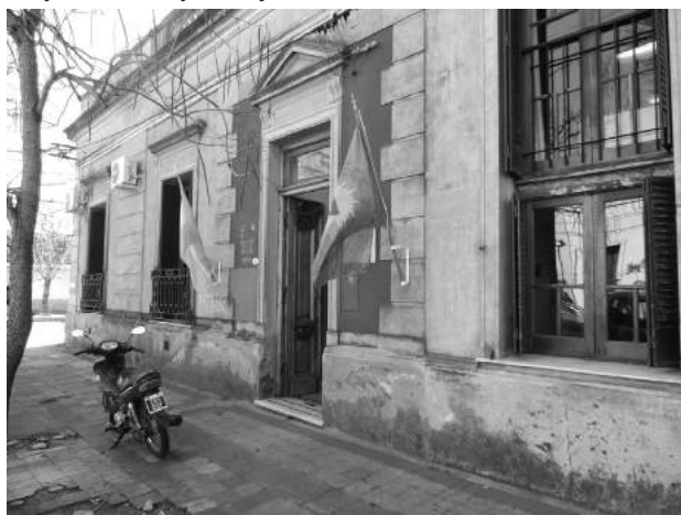
Edificio de Jefatura ubicado en Libertad y Poratti. Fotos De Sogos.
