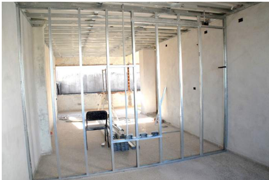
Intenso ritmo de trabajo se observa en lo que será el nuevo centro de monitoreo de cámaras de seguridad de la Municipalidad de Nueve de Julio, que se instalará en el último piso del
