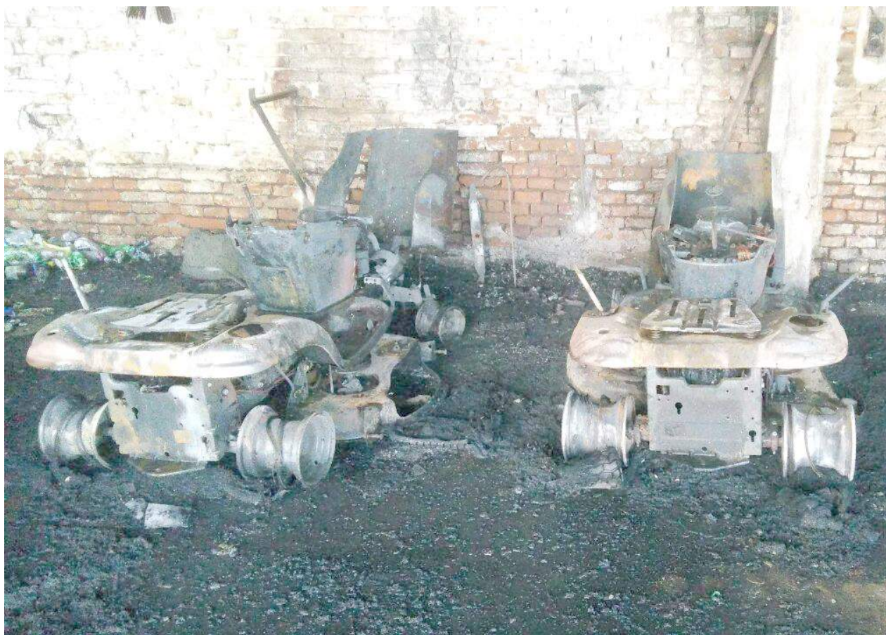
Importantes daños materiales sufrió el edificio de la Delegación.
