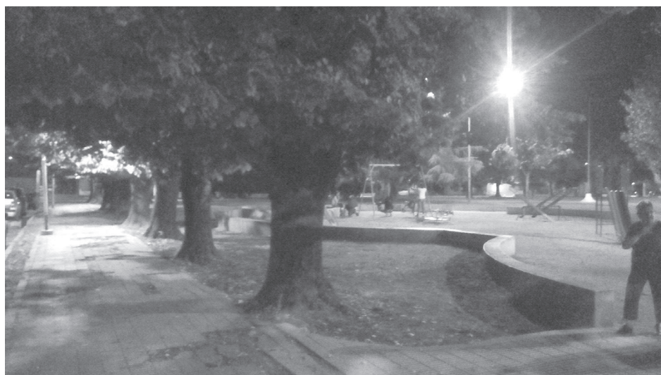
Vista de las nuevas luminarias colocadas en Plaza España.
