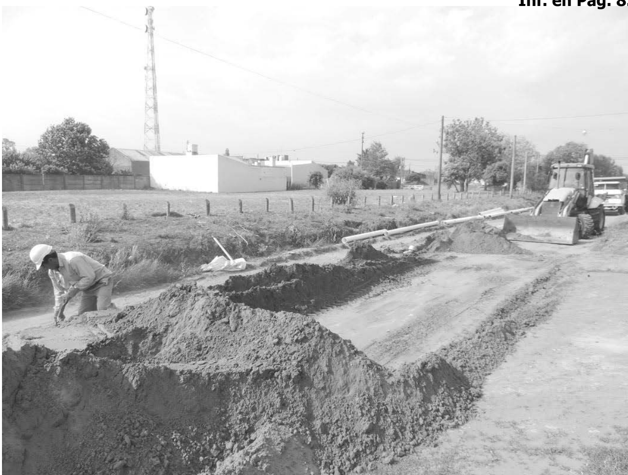
A buen ritmo se lleva adelante la importante obra de cloacas.
