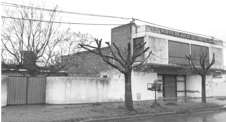
Vista de la sede ubicada en Av. Tomás Cosentino al 600, casi Tucumán. Foto De Sogós.
