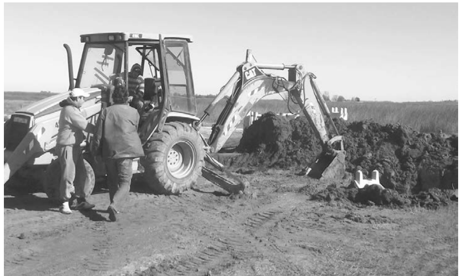
Maquinarias que trabajaban en el alcantarillado al límite de nuestro Partido.
