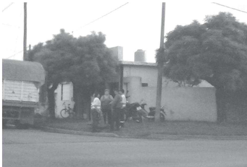
Graves daños causó el fuego a la vivienda ubicada en Heredia y Cavallari. Foto De Sogos.
