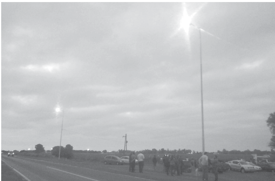
Vista de las dos luminarias ubicadas en la bajada a El Provincial, por ruta 65.
