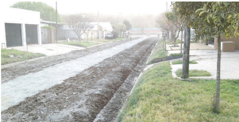
La Municipalidad de Nueve de Julio, a través de la Secretaría de Obras y Servicios Públicos, comenzó en la jornada de ayer, martes 6, las obras de asfaltado en barrio
