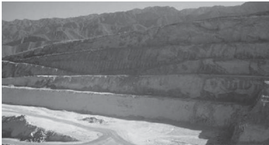
Calidra realizará una inversión de 50 millones de dólares para instalar dos hornos Maerz de última tecnología de calcinación en la calera sanjuanina ubicada en la Ruta 153. Foto ilustrativa: Diario Huarpe/InfoGEI.
